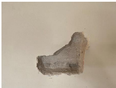
Fotografia przedstawiająca widok konstrukcji słupów, filarów ściennych oraz ścian działowych
