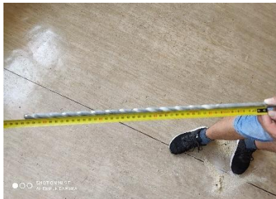
Fotografia przedstawiająca odwiert warstw stropu nad piwnicą
