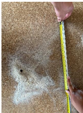
Fotografia przedstawiająca odwiert warstw podłogi na gruncie
