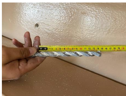
Fotografia przedstawiająca grubość wypełnienia ceglanej ramy (podpory środkowej)
