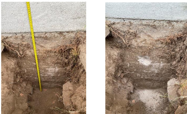
Fotografie przedstawiające widok ściany fundamentowej podczas prac odkrywkowych
