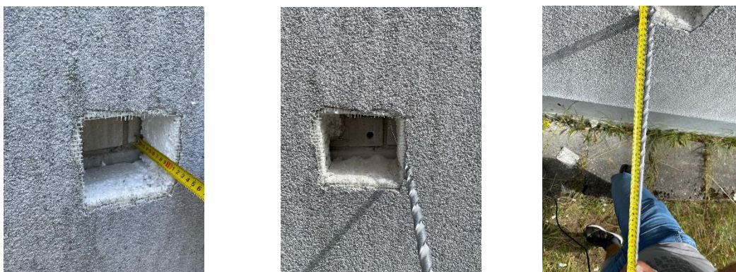
Fotografie przedstawiające widok ściany przyziemia podczas prac odkrywkowych
