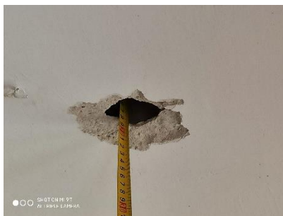
Fotografia przedstawiająca widok konstrukcji stropodachu niewentylowanego Widok pustaka ze stropu gęstożebrowego DZ-4
